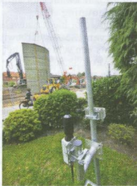
Met verplaatsbare draadloze sensoren wordt het lawaai voortdurend in de gaten gehouden. Foto: Toma Tudor
